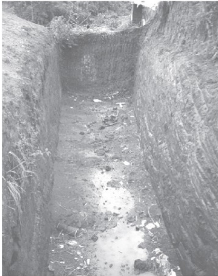
Figura N° 1. Fosa para el enterramiento de aves.
